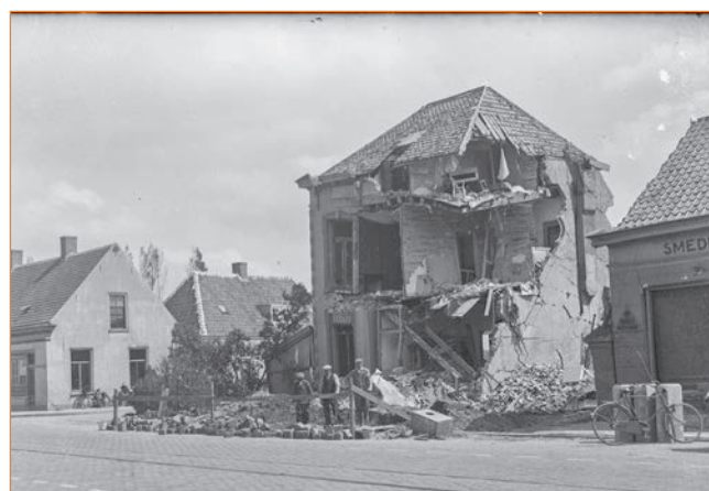
Oorlogsschade aan de voormalige Villa De Bourbon door luchtbombardement, mei 1940. De panden links bestaan nog. Door: Fotopersbureau Het Zuiden, GN19901817, collectie Stadsarchief Breda
